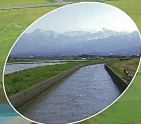
中江幹線水路
