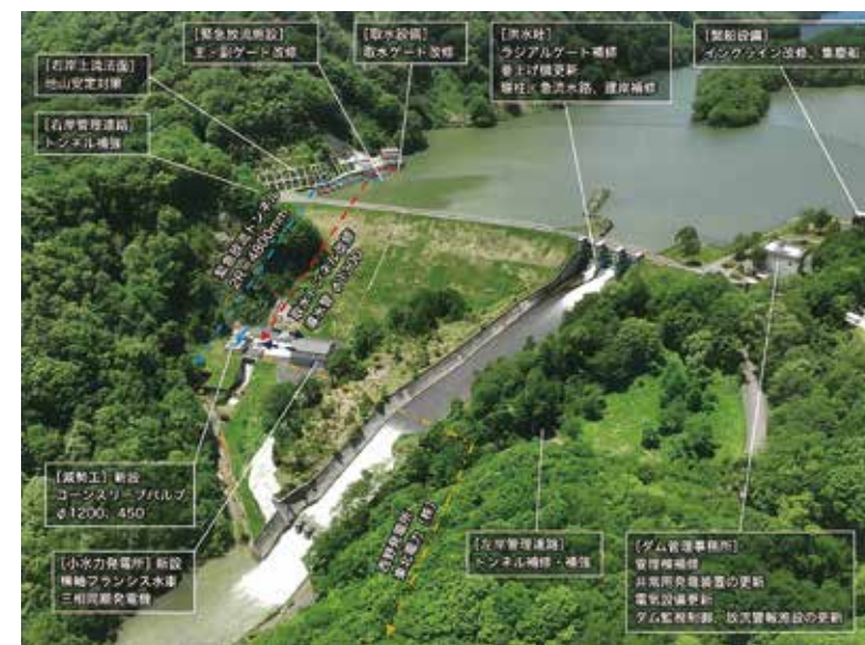
事業が完了した笹ヶ峰ダム
