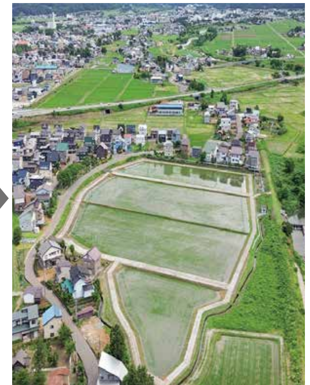
柳井田地区 R7年度面工事完了
