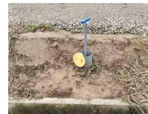
暗渠排水の水閘
