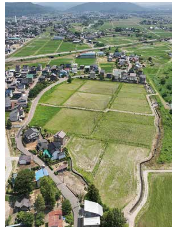
柳井田地区 R7年度面工事着手前
