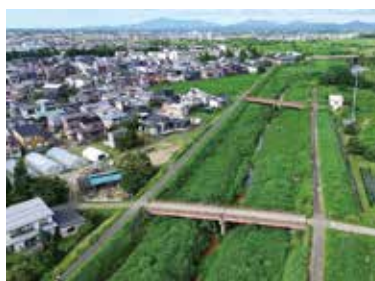
手前：丸山橋 奥：瀬違橋
